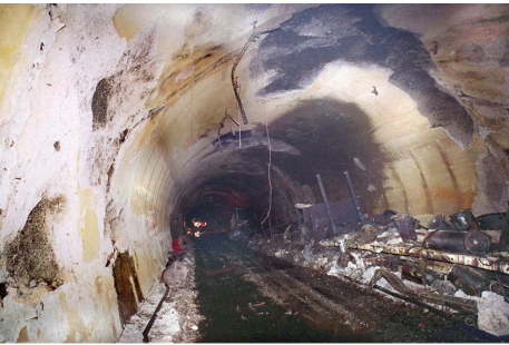
Tunnels (Mont Blanc, 1999)
